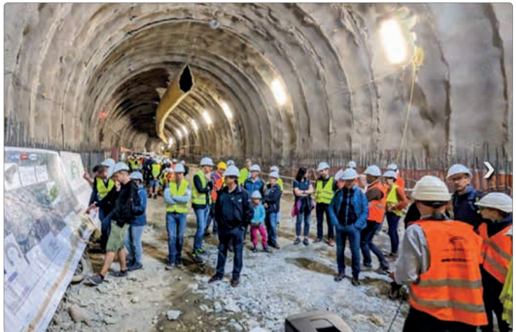
Rund 1.500 Interessierte haben sich direkt im Tunnel Küchelberg über den Baufortschritt der rund drei Kilometer langen Nord-West-Umfahrung von Meran informiert. Es wurden bisher 1.600 Meter ausgebrochen; es fehlen somit noch 600 Meter bis der Tunnel komplett aufgefahren ist, hieß es beim Tag des offenen Tunnels. (Foto: LPA/Ingo Dejaco)
