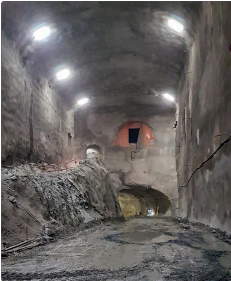
Hauptkaverne Bauzustand Anfang Dezember 2024
