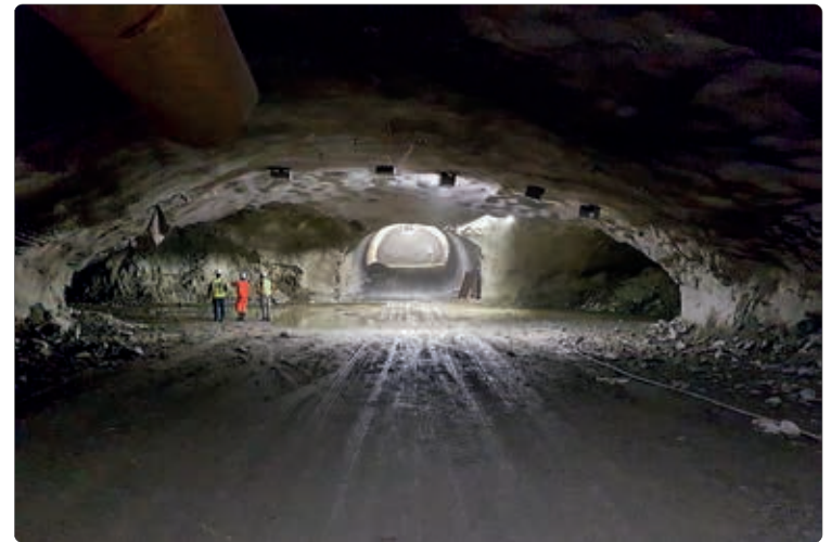
Hauptkaverne Bauzustand Juli 2023
